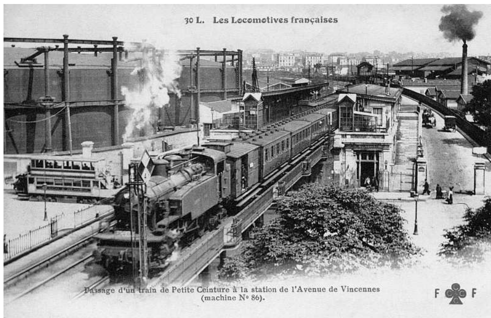
Un train franchit le viaduc du Cours de Vincennes vers 1910.
