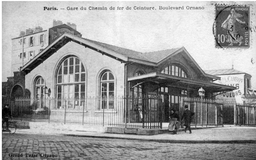
Un exemple du modèle de gare-pont de la Petite Ceinture Rive Droite
